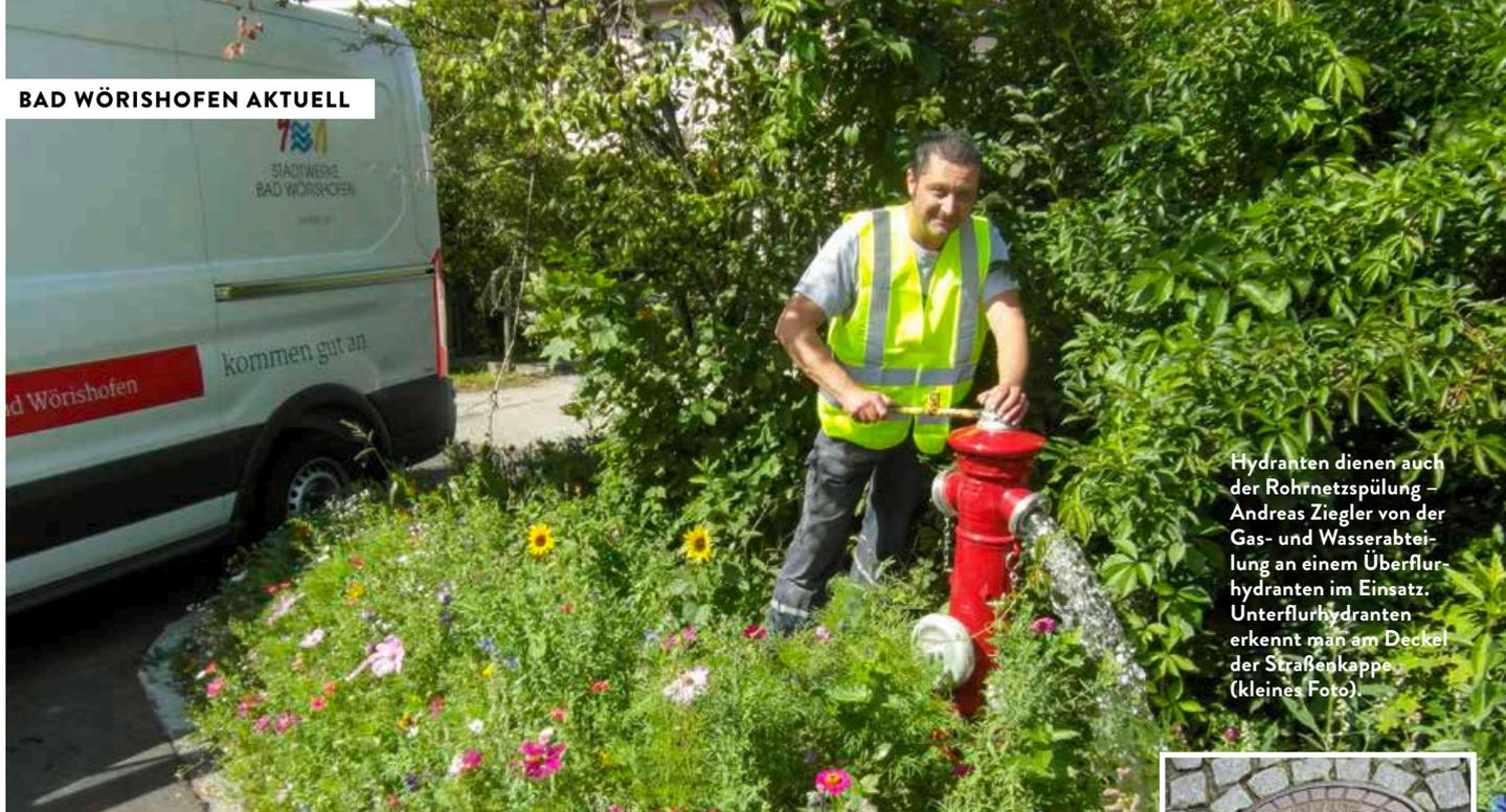
Hydranten dienen auch der Rohrnetzspülung – Andreas Ziegler von der Gas- und Wasserabteilung an einem Überflurhydranten im Einsatz. Unterflurhydranten erkennt man am Deckel der Straßenkappe (kleines Foto).
